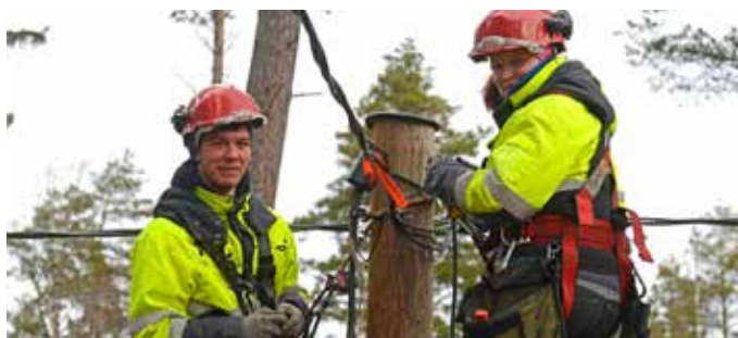
Den nya övningslinjen byggdes under året. Där får elever praktisera linjebyggande i verklig miljö.
